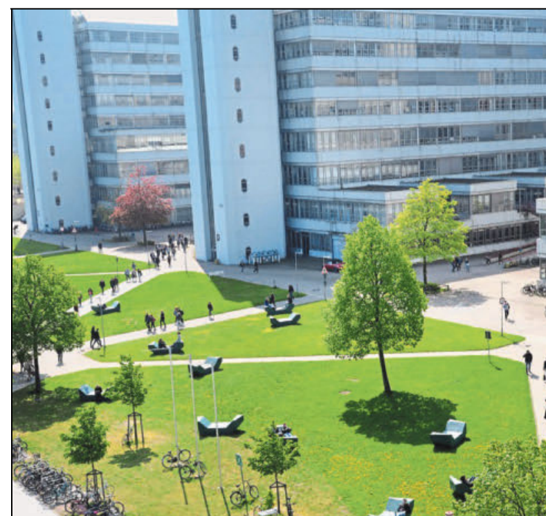
Die Kosten für die Sanierung des Uni-Hauptgebäudes haben sich für den ersten Bauabschnitt von 132 Millionen Euro auf inzwischen etwa 255 Millionen Euro nahezu verdoppelt. Foto: Schwabe
