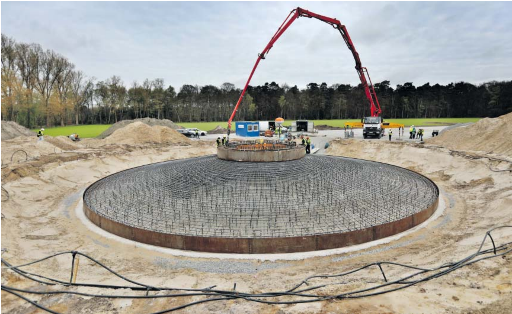
Windpark Hasselbach: Dieses aus Stahl geflochtene Gebilde erinnert irgendwie an einen überdimensionalen Topfdeckel. Dieser Bewehrungskorb mit 30 Metern Durchmesser, der bald als Fundament für eine Windkraftanlage dient, wird über den roten Rüssel der Autobetonpumpe mit Zement verfüllt.
