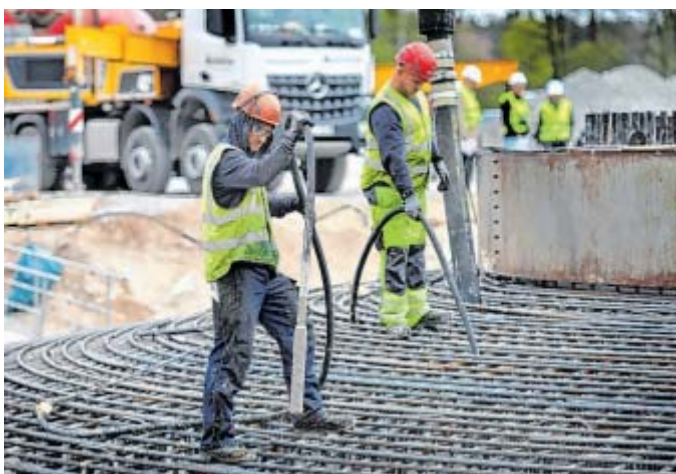
Endspurt: Einen ganzen Tag lang dauert es, bis der Stahlkorb mit rund 1.000 Kubikmeter Beton verfüllt ist.
