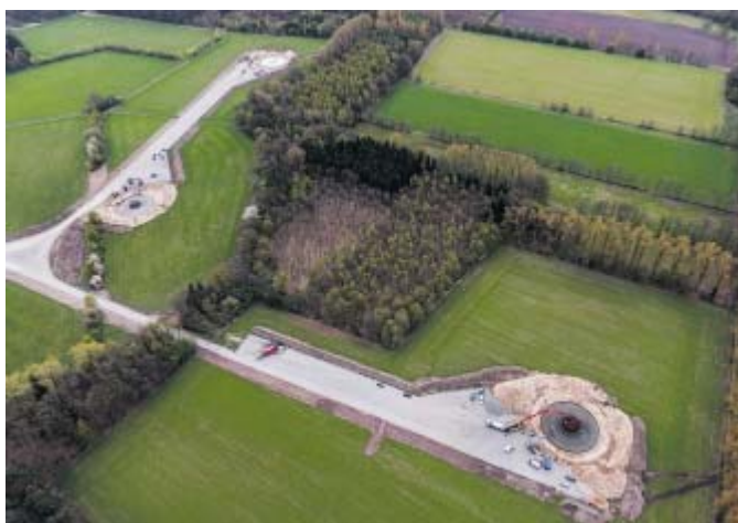
Aus der Luft: Links die Anlagenstandorte auf Bielefelder Gebiet, der Waldstreifen markiert die Grenze zu Verl.
