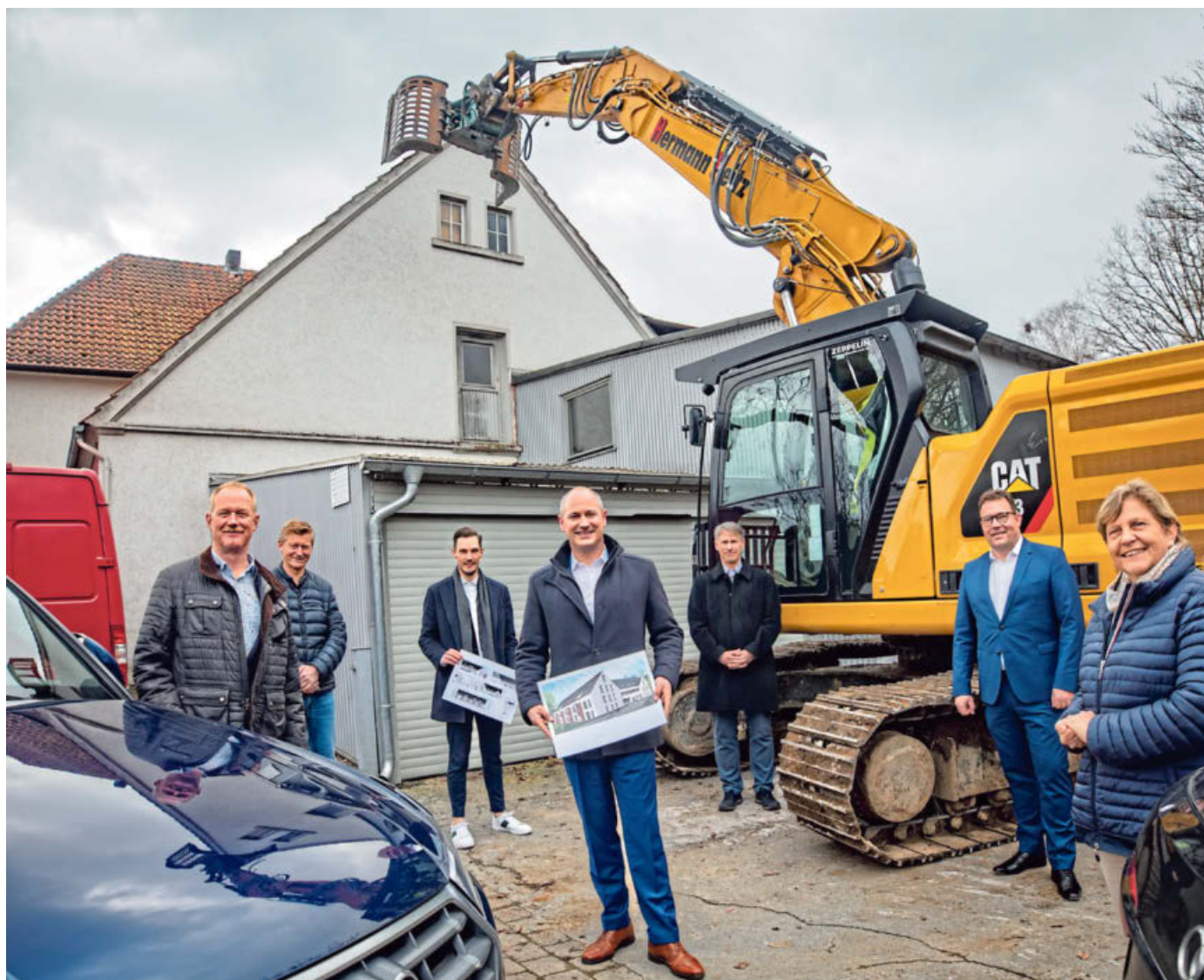
Freuen sich vor dem Abrissbagger auf das hier bald neu entstehende Wohnprojekt am Johannisbach: Werner Kordtomeikel, Thomas Herzog, André Winter, Matthias Löwen, Christian Steinpass, Axel Kirschberger und Heike Winter (von links). FOTO: MIKE-DENNIS MÜLLER
