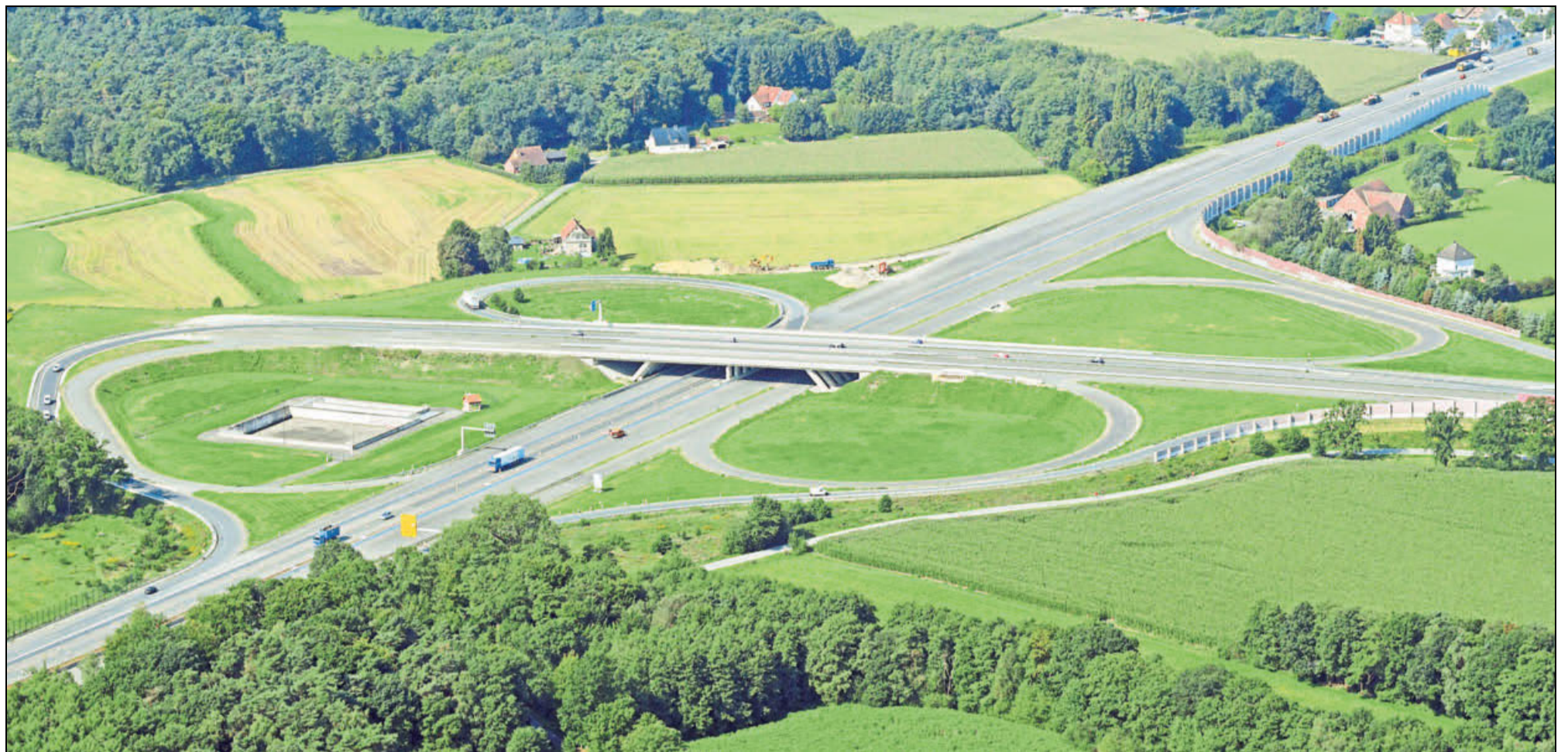
Vom Kreuz mit dem Ostwestfalen-Damm aus soll der Verkehr vom 4. April an auf der A 33 in Richtung Steinhagen fließen.
